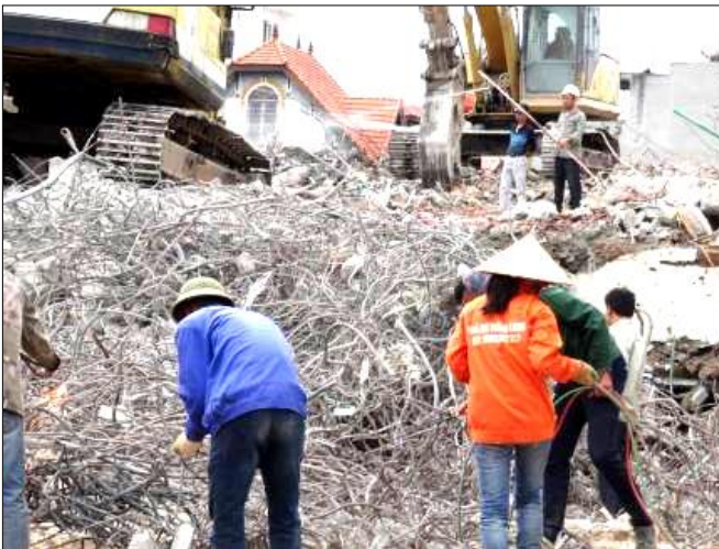
Hier wurde ein Haus abgerissen
